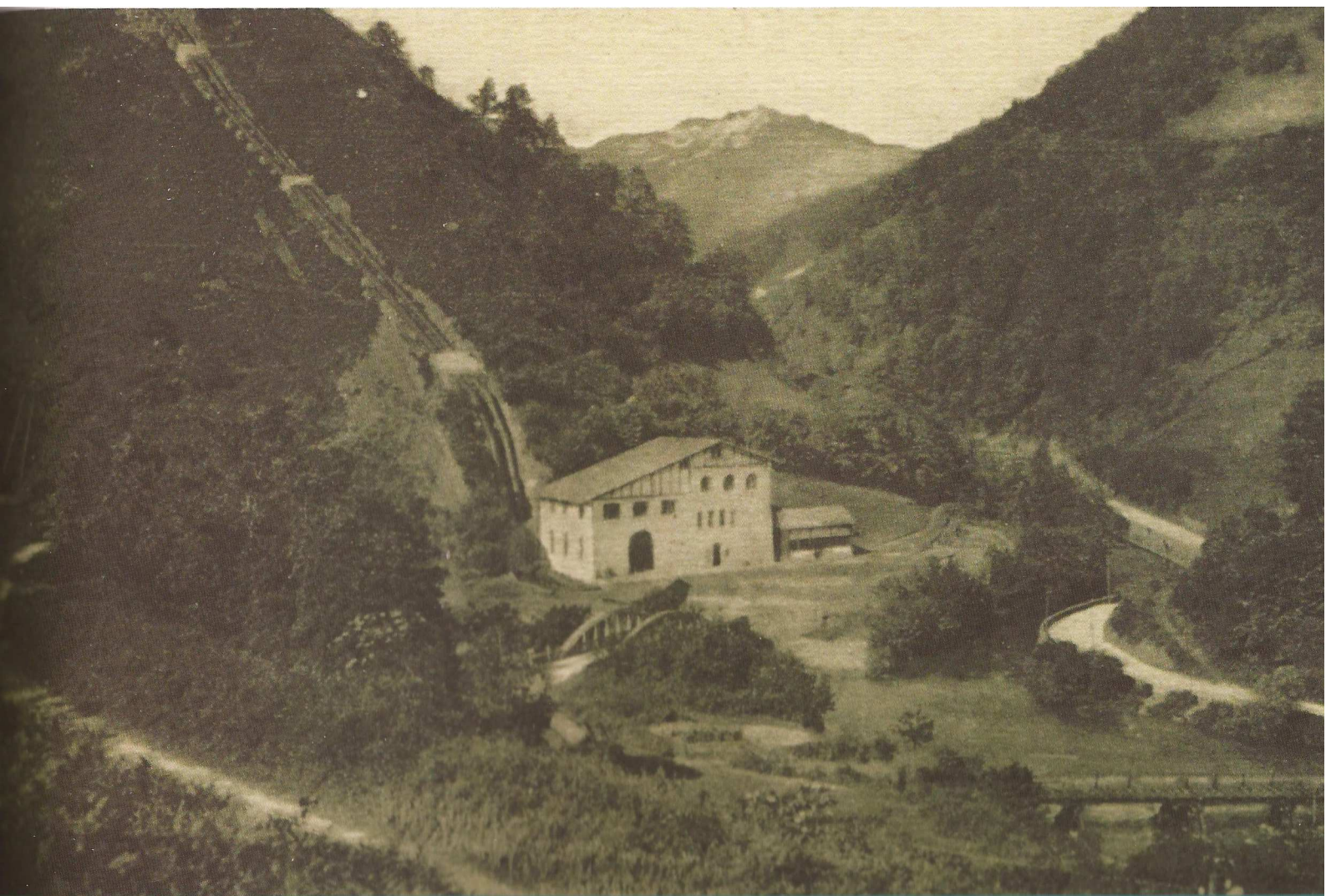
L'usine électrique de Licq-Athérey, au premier plan la ligne forestière
