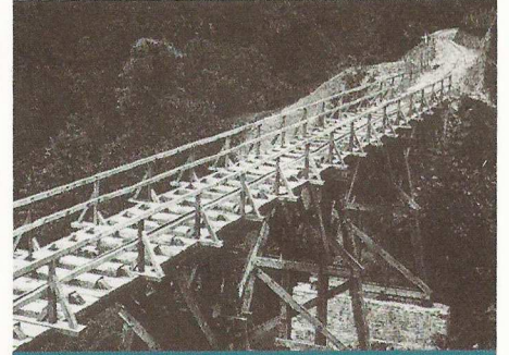
Pont en bois au km 16
