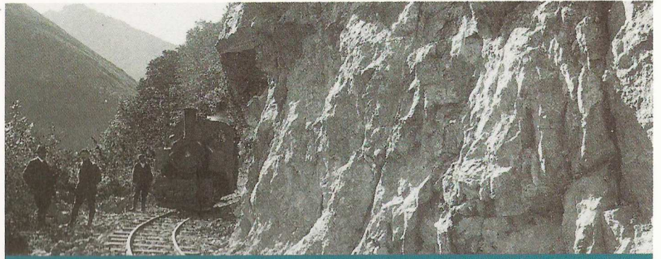
La tranchée d'Ehoriage
